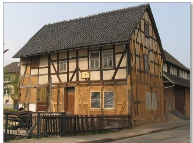
Vor der Sanierung
