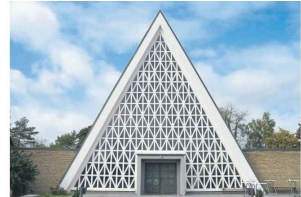
Große Investition: Mit rund 1,2 Millionen Euro wurde die katholische Kirche in Trutzhain saniert. Am Samstag lud die Gemeinde zur Besichtigung ein. FOTO: REGINA ZIEGLER-DÖRHÖFER
